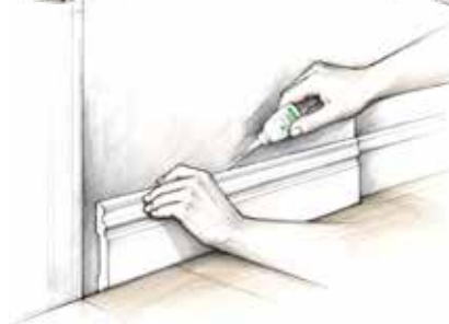
7. ใช้กาวร้อนหยอดเป็นระยะๆ เพื่อให้ไม้บัว YES MOULDING ยึดติดผนังในขณะ ที่กาวฟลึงตะปูทำการเช็ทตัวอยู่
